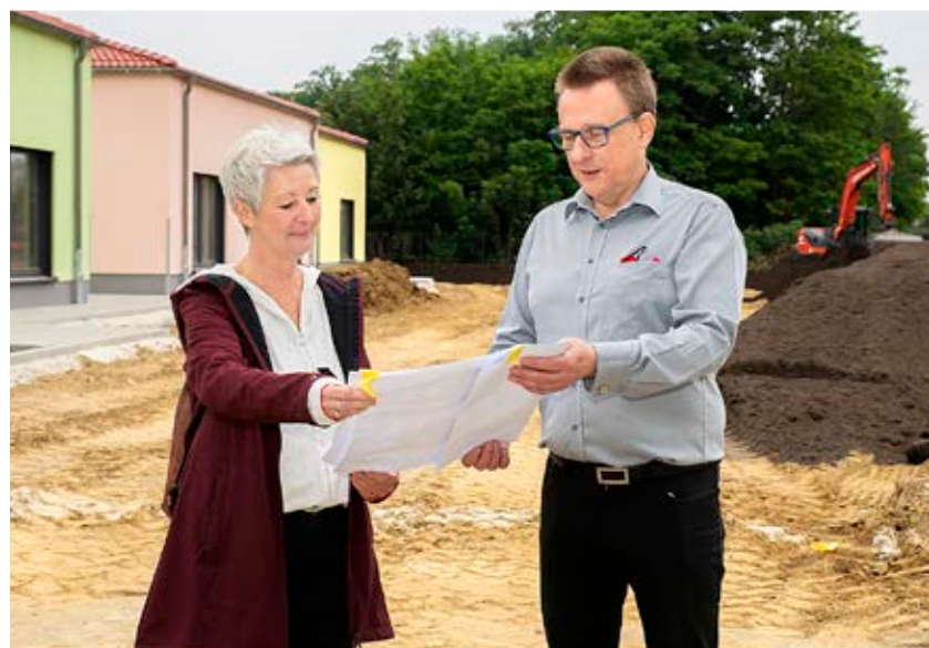
Bald wird hier gespielt! Ute Höppe-Skroch, Koordinatorin Kindertagesbetreuung, und Jugendamtsleiter Peter Wenzel schauen nach den Fortschritten auf der Baustelle der Kanello-Kita.
